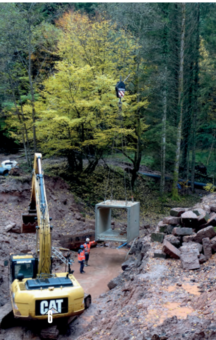
Pose d'un ouvrage sur la Maix | FD88
