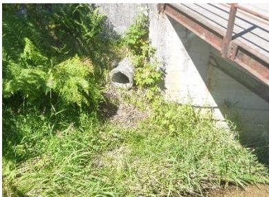
Figure 26 : Rejet buse béton
